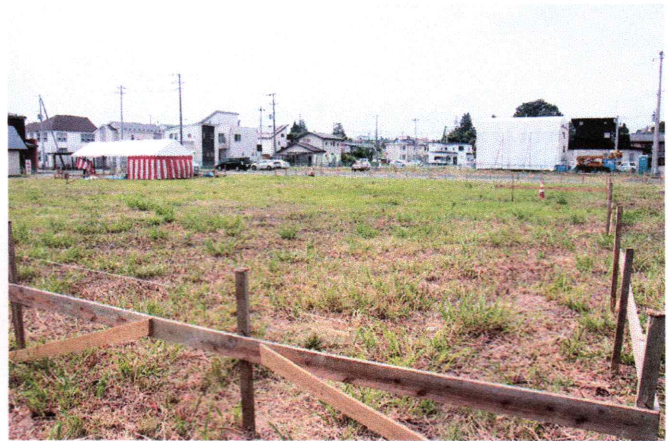
認定こども園の園舎が新築される建設地。奥右が石鳥谷駅
